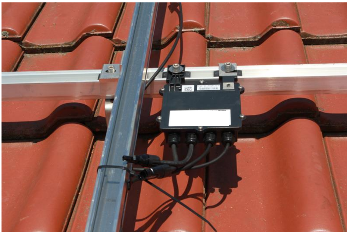
Rys. 2. Montaż optymalizatora do szyny montażowej.
