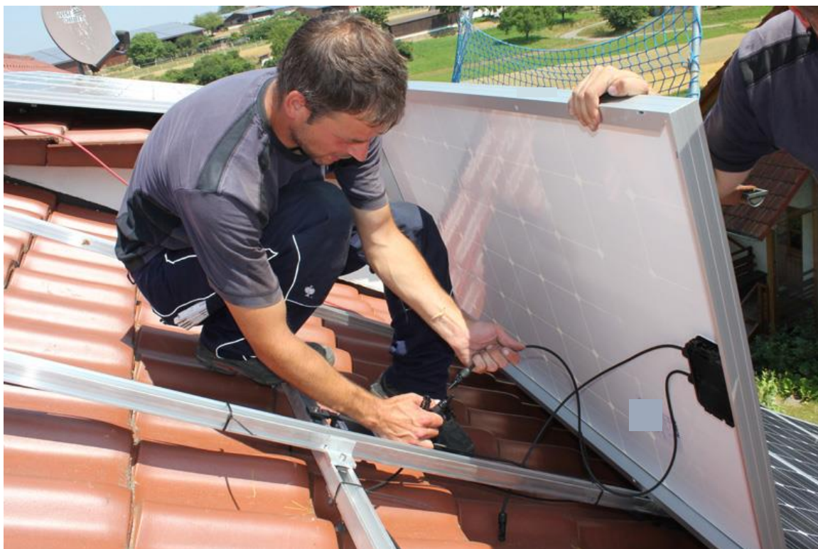
Rys. 3 Sposób podłączenia optymalizatora z modułem PV.
