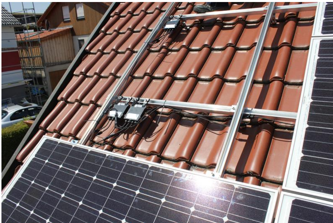
Rys. 1 Połączenie szeregowe optymalizatorów.
